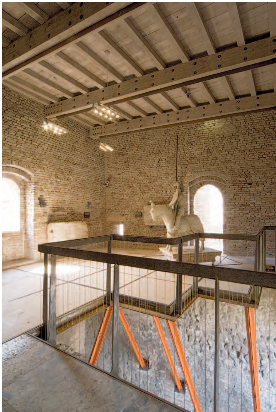
1. L'allestimento di G. Tommasi: il solaio ligneo e i puntoni che lo sostengono.
